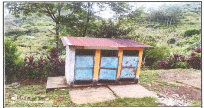
Foto 6: Cambiar techos del baño y pintar las puertas.
