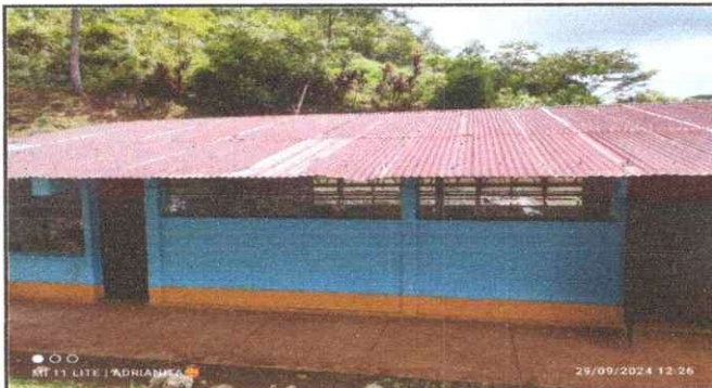
Foto 3: Cambiar pintura de la pared y de las puertas.
