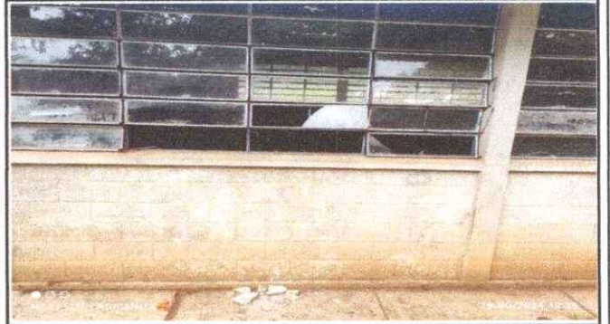
Foto 2: Cambio de algunos vidrios rotos.
